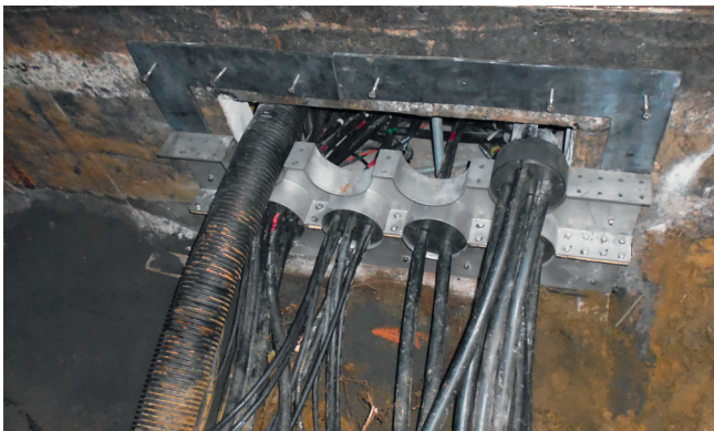
Per sectie montage van flensplaten met extra lange pluggen en roestvrij stalen schroeven.
