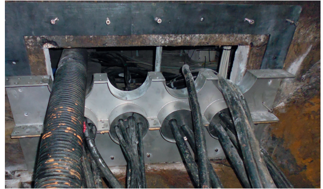
Platte afdichting met Sikaflex afdichtmassa op de wand.
