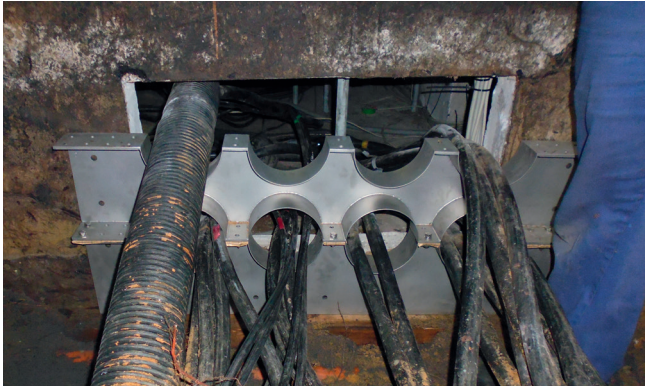
Aanbrenging van de voormonteerde flensplaten en markering van de montagepunten voor de wanddoorvoer.
