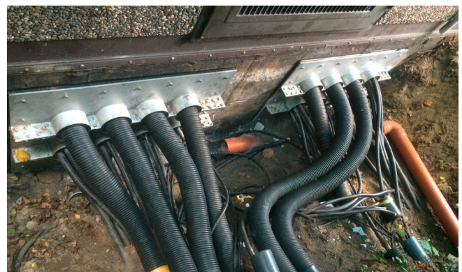
Nieuwe wanddoorvoer met kabel- en bescherm buizen voor het hernieuwd opvullen.
