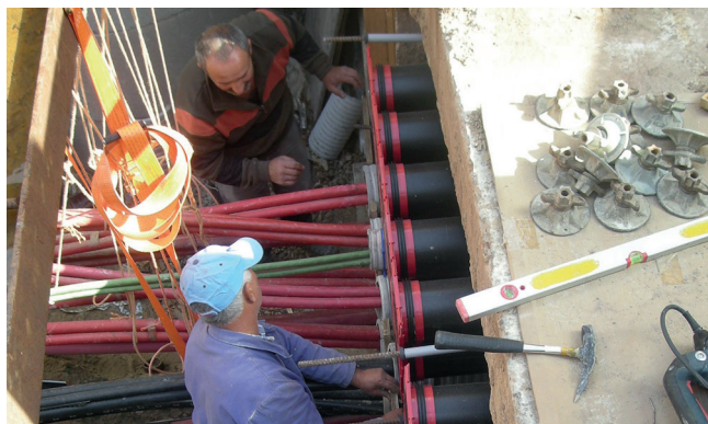
Inbouw van de afdichtpakkingen HSI 150-K2 en de gesplitste doorvoerbuizen FZR-G.
