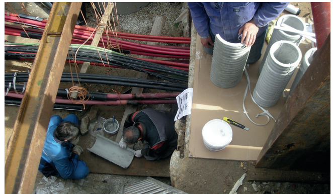
Montage van de gesplitste vezelcement-doorvoerbuis FZR-G.
