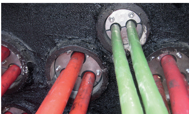
Alle kabels werden achteraf met gesplitste, op maat gefabriceerde HRD-druk dichtingen in de doorvoerbuizen afgedicht.
