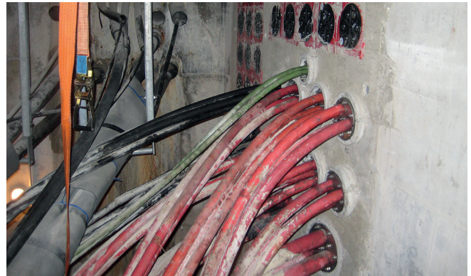
Toestand van de duiker na de sanering: er werden vervangende doorvoerkanalen aangelegd. Rond de aangelegde kabels werden gesplitste doorvoerbuizen gemonteerd. Op die manier werd de afdichting van de wand boven de doorvoerbuizen tot aan de kabels gegarandeerd.
